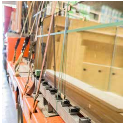
Die gesamte Holzkonstruktion eines Wohnhauses durchschnittlicher Größe wird mit 2-3 LKW-Ladungen transportiert
