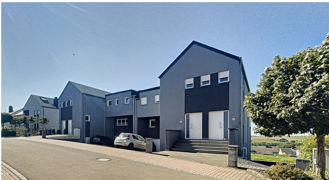
Photo extérieure - façade avant
