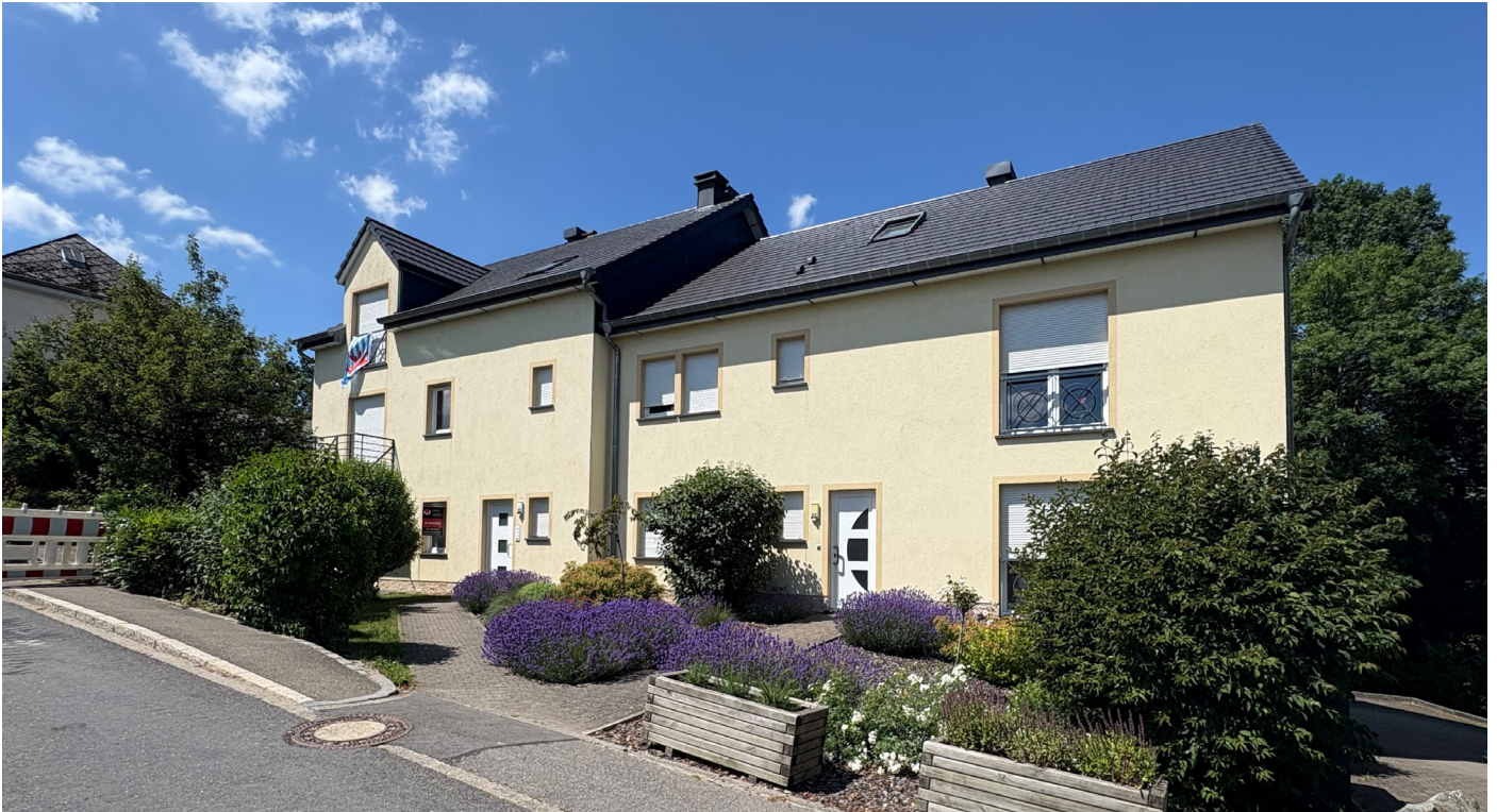
Photo extérieure - façade avant
