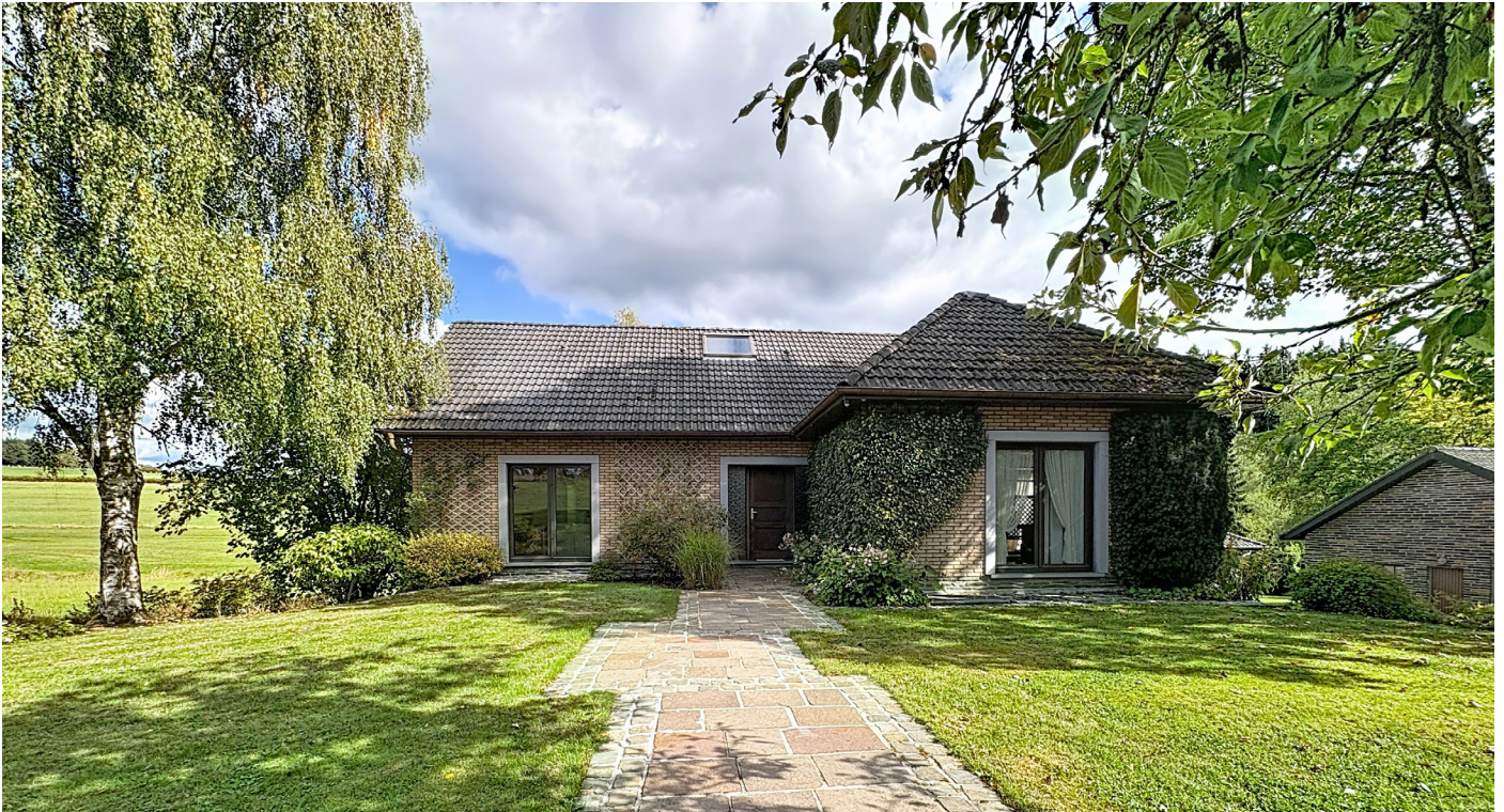
Außenfoto – Vorderansicht / Fassade
